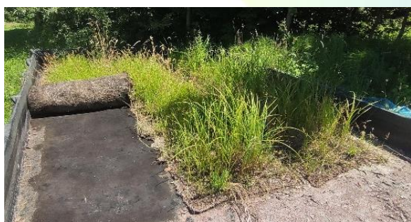
→ Transport facilité par roulage des nattes
